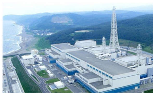
柏崎刈羽原子力発電所
